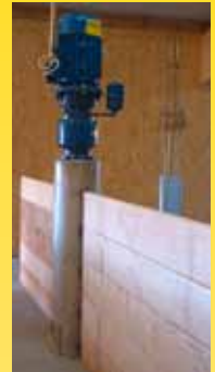
Antrieb mit Planetengetriebe auf Säule Entraînement par engrenage planétaire sur pilier
