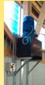
Hydraulikaggregat, stufenlose Geschwindigkeitsverstellung vorwärts/rückwärts Agrégat hydraulique, réglage de vitesse en continu en avant et en arrière
